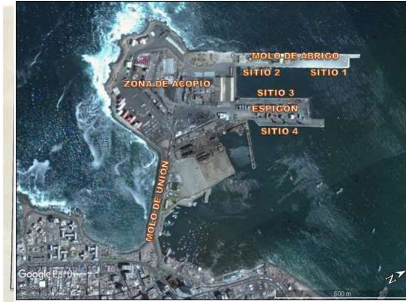
Figura 6.8: Infraestructura Puerto de Iquique. FUENTE: MODIFICADA DE GOOGLE EARTH.
