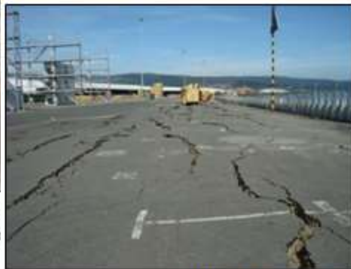
Figura D.41: Grietas en el pavimento de zona de acopio.
