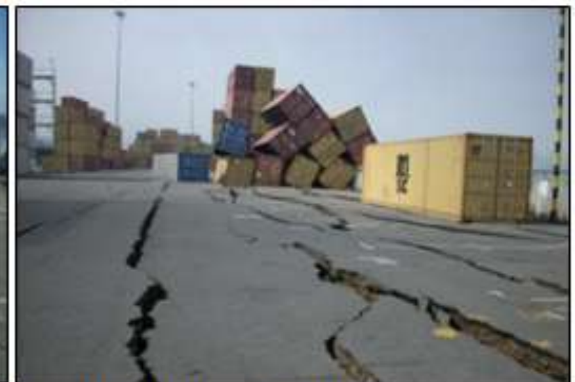
Figura D.41: Grietas en el pavimento de zona de acopio.
