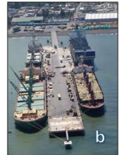
Figura 3.16: Tipos de muelle: a) Muelle marginal; b) Muelle perpendicular.
