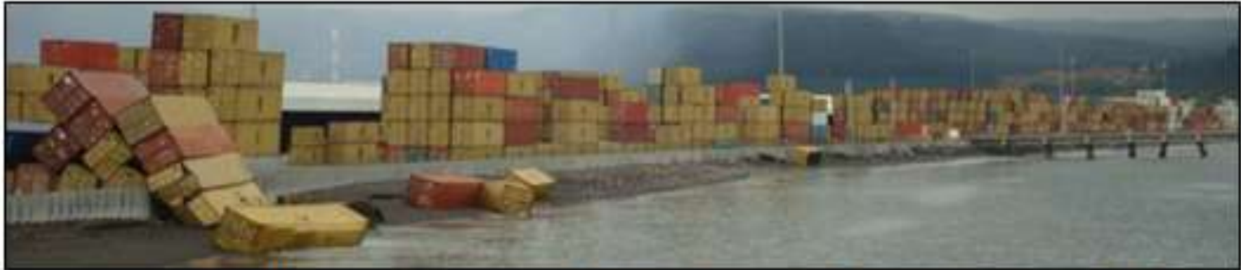
Figura D.44: Desplome de pilas de containers en sector de acopio, Puerto Coronel.
